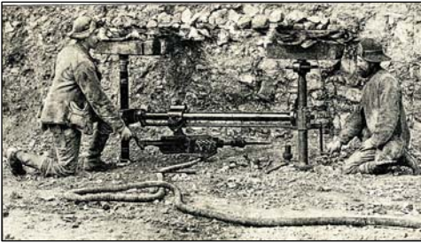
Einsatz des Gestells beim Schrämen des Flözes Einsatz des Gestells beim Bohren der Löcher
