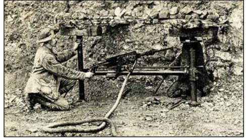
Einsatz des Gestells beim Schrämen des Flözes Einsatz des Gestells beim Bohren der Löcher
