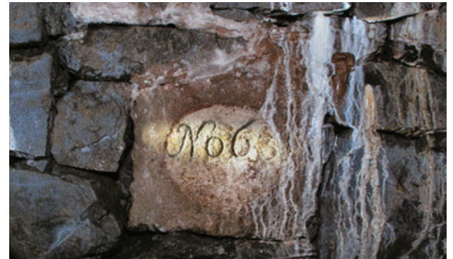
In Stein geschlagene Ortstafel des Lichtloches 63 des Froschmühlen-Stollens. (Foto: Andreas Elste)
