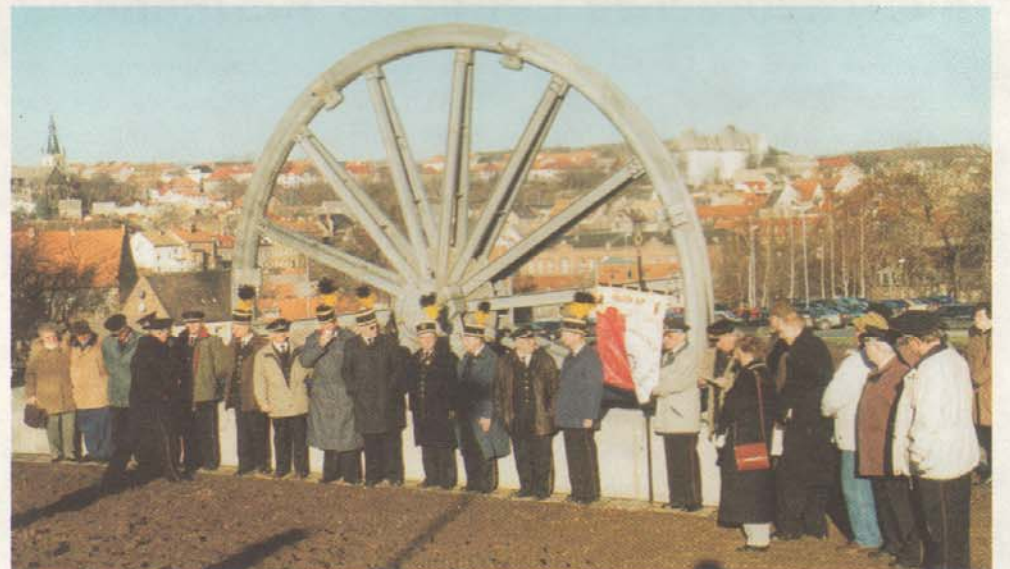
Vom Stand der Arbeiten an der Seilscheibe überzeugten sich am 19.01.2000 Mitglieder des Vereins, Vertreter der Stadt, interessierte Bürger sowie an der Realisierung beteiligten Firmen.
